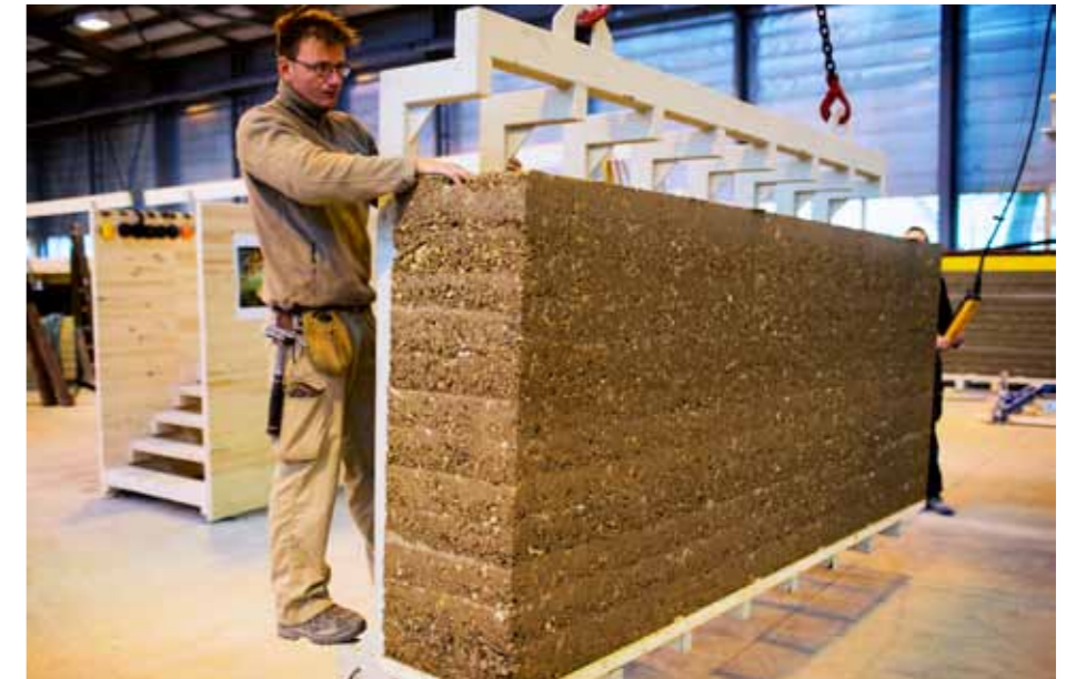
In nahegelegenen Hallen werden die einzelnen Elemente der Lehmfassade vorgefertigt.
