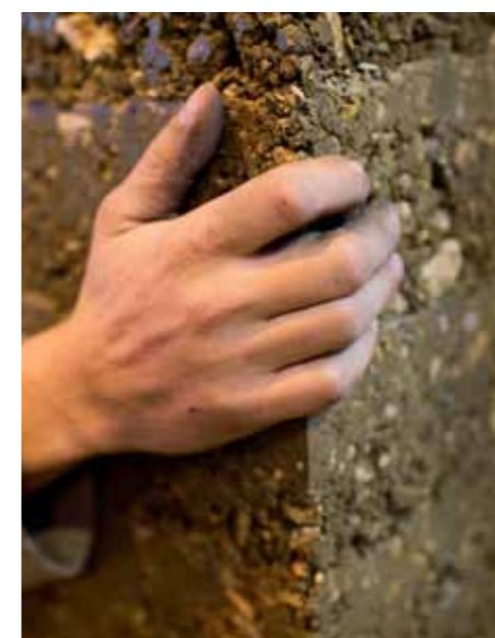
Gut ist hier die körnige Struktur des gepressten Lehms zu sehen.
