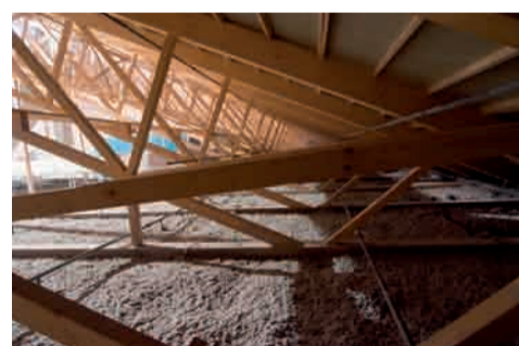
Schwer zugängliche Stellen – einfach gedämmt
