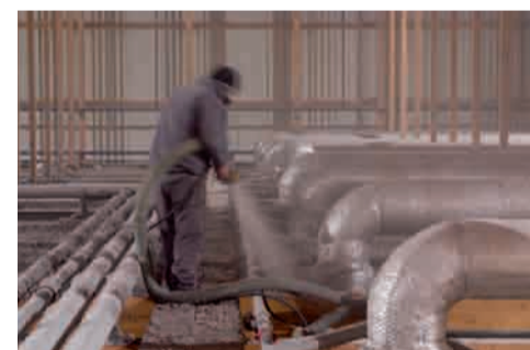
Dämmen beim Vorbeigehen mit isofloc
