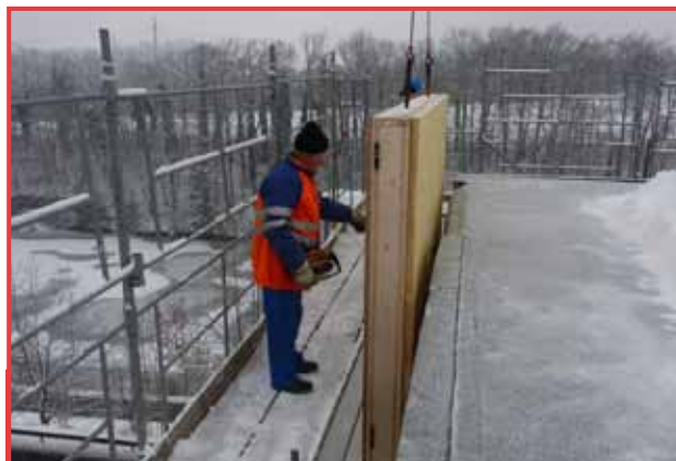
Pose des éléments périphériques et préfabriqués (© Lutz architectes)
