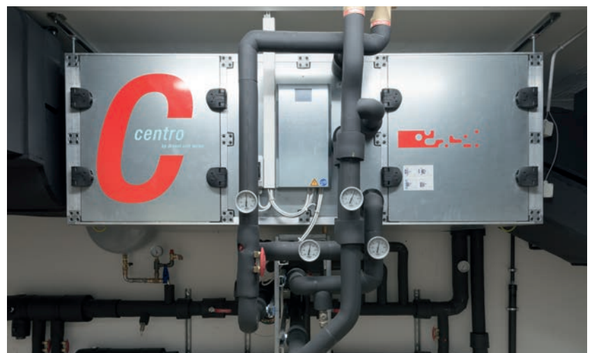
Zentrales Lüftungsgerät aerosilent® centro by drexel und weiss
